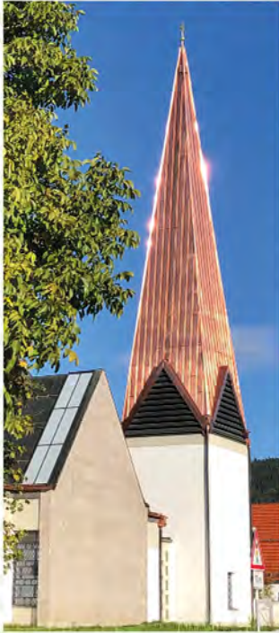
Erneuerung des Kirchturmdaches der Marienkirche
