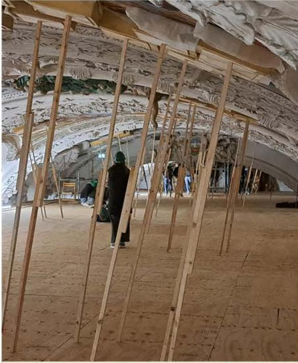
Dutzende Abstützungen sichern während der Bauarbeiten die Asambilder vor Beschädigung
